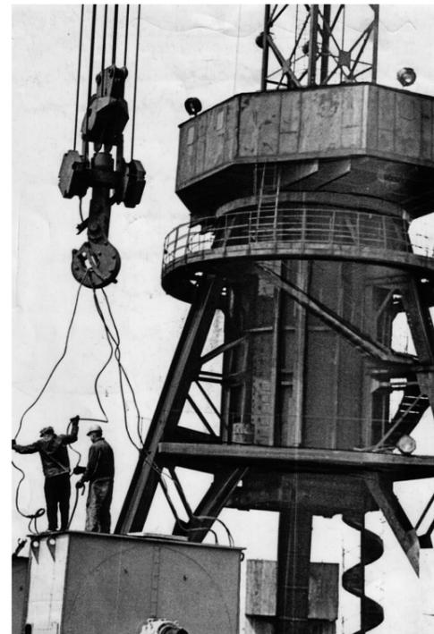
Монтаж котла пятого энергоблока Новочеркасской ГРЭС с помощью 50-тонного башенного крана, 1968 год
